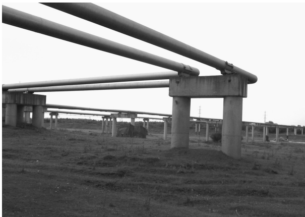
Рис.1. Надземний перехід магістрального газопроводу (МГ) через заплаву річки Стрий
