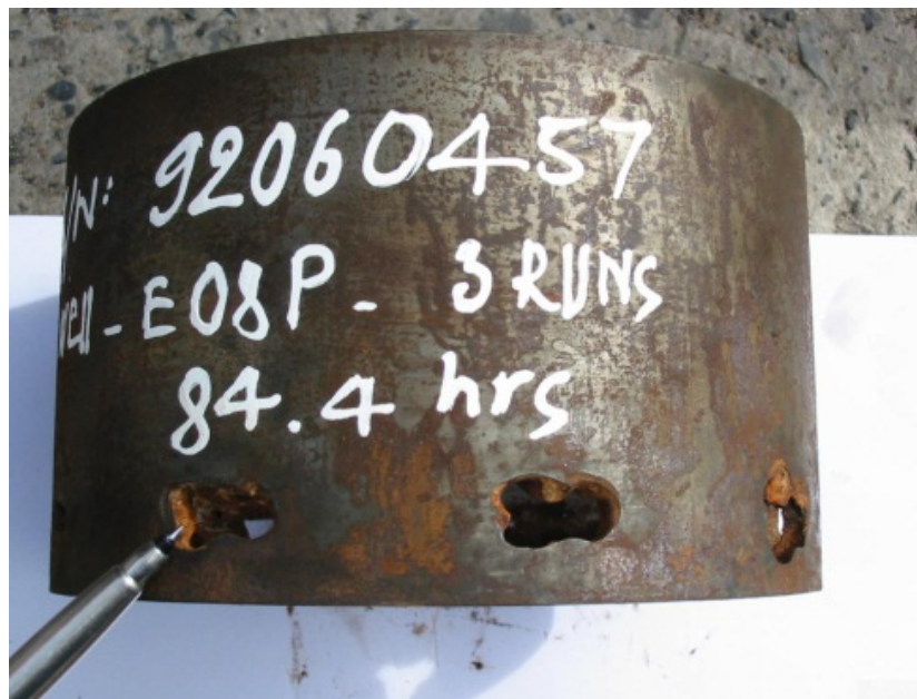
Рисунок 1.3 – Ерозійне пошкодження обсадної труби
