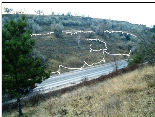
Рис. 2. Формирование оползней течения, что представляют угрозу автодороге: а) оплывины в откосах выемки автодороги Кишинев–Черновцы; б) сплывы в насыпи автодороги Кишинев–Черновцы
