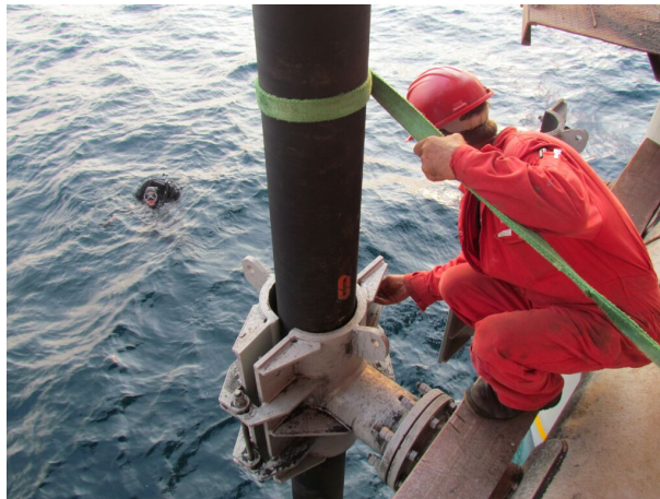
Рисунок 2 – Монтаж морського стояка в морі
