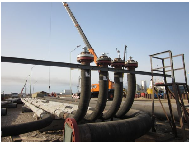
Рисунок 1 – Зварювання секції стояка на будівельному майданчику
