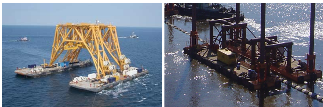
Рисунок 15 – Плаваючі опори розміщені на баржах
