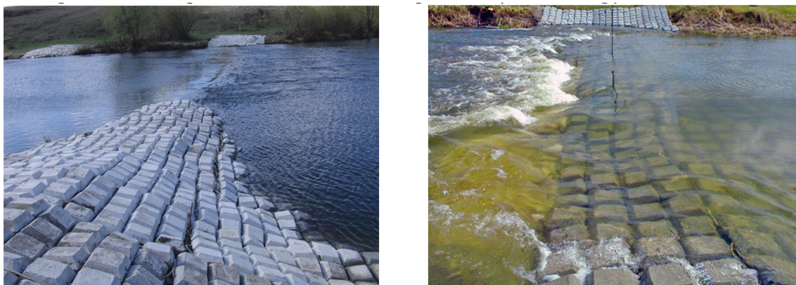
Рисунок 6 – Укладений на дно річки трубопровід, захищений універсальними гнучкими захисними бетонними матами
