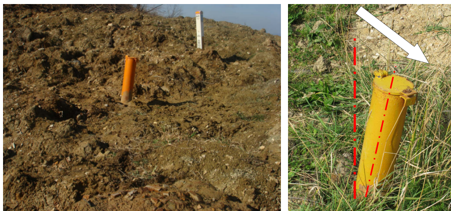
Рисунок 4 – Вигляд зсувної ділянки та поста тензометричного контролю напружено-деформованого стану трубопроводу (на ділянці газопроводу «Пасічна-Долина» Ду 500, поблизу с. Битків)
