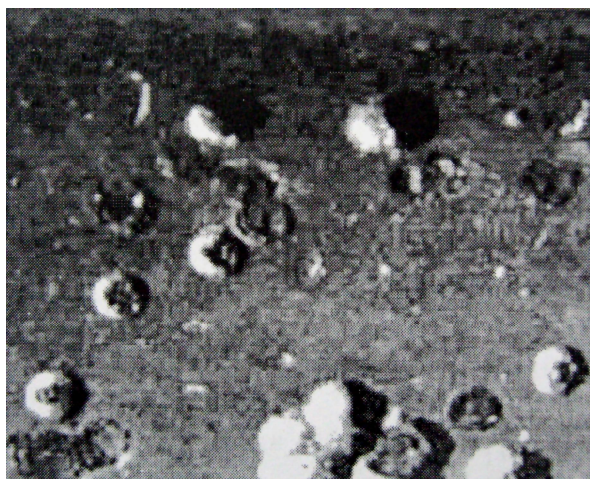
Рисунок 1 – Утворення корозійних язв, заповнених об'ємними продуктами корозії, в результаті дії СВБ на сталевий трубопровід
