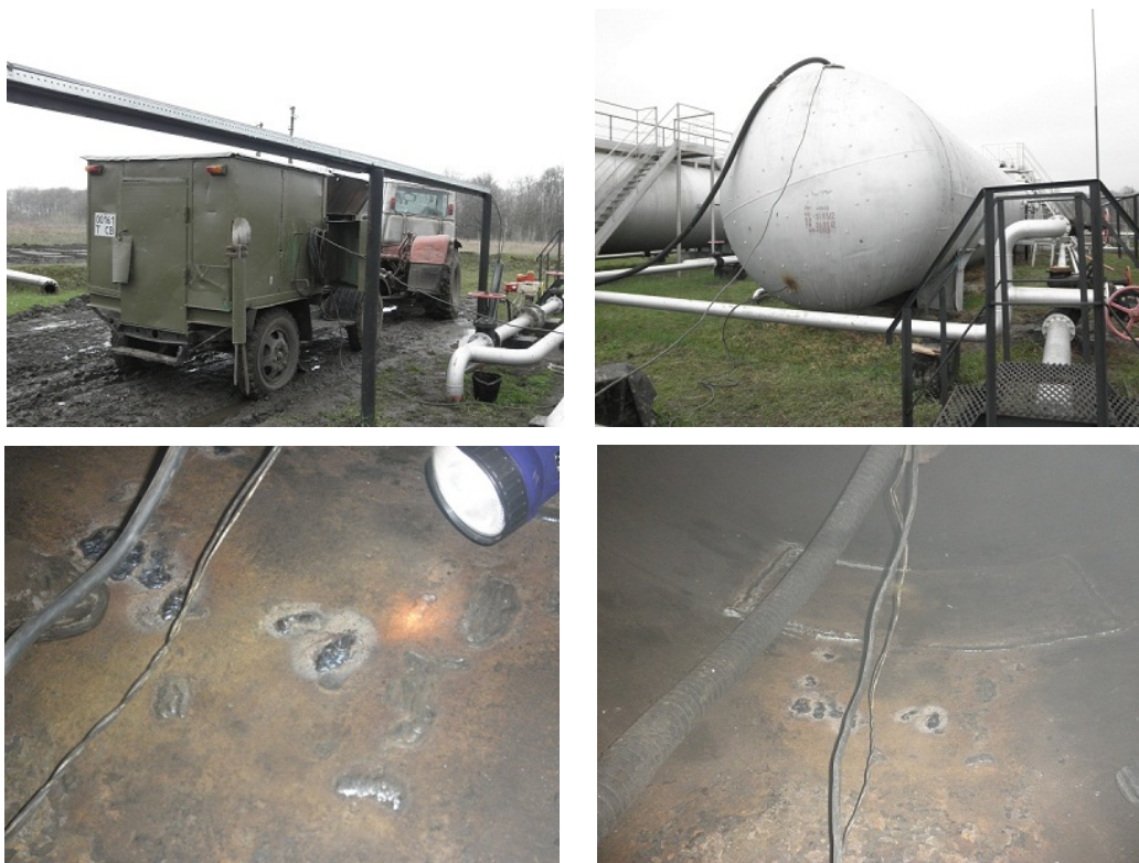
Рисунок 4 – Ремонт і контроль виконання зварювальних робіт
