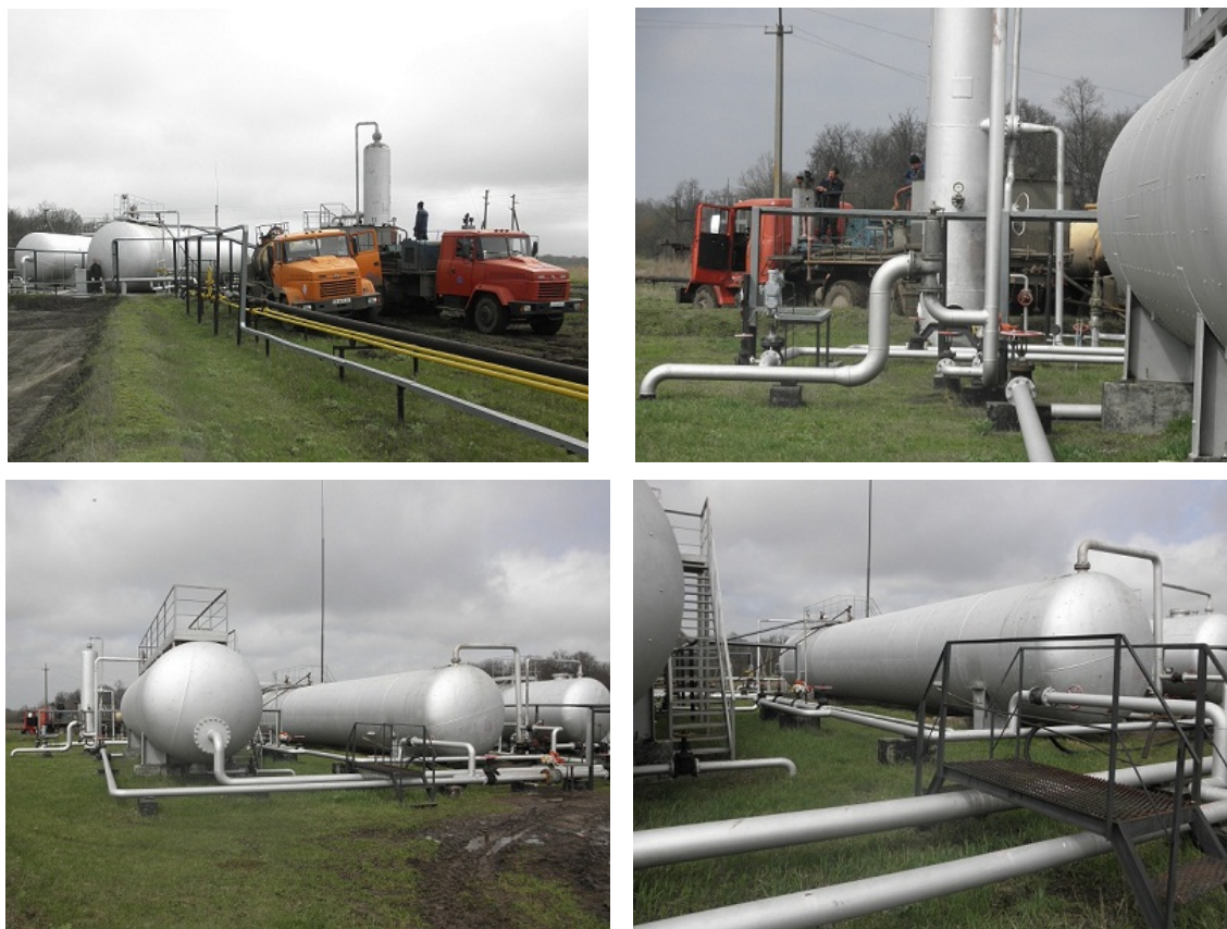
Рисунок 5 – Проведення гідравлічного випробування ємності ПЕ 200-16 ГС
