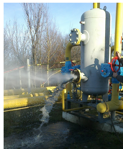
Рисунок 4 – Аварійне випускання газу і рідини в атмосферу з порожнини газопроводу у випадку припинення газопостачання з причини утворення рідинних скупчень значних об'ємів
