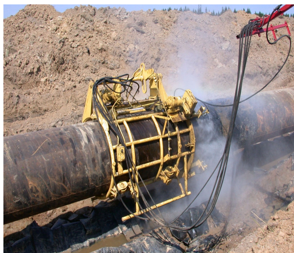
Рисунок 8 – Універсальна самохідна машина для видалення старої ізоляції
