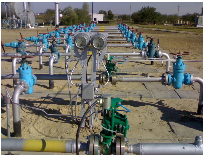
Рисунок 1 – Комплекс автоматичного відбору газу, змонтований на УКПГ №3 Шебелинського ГКР
