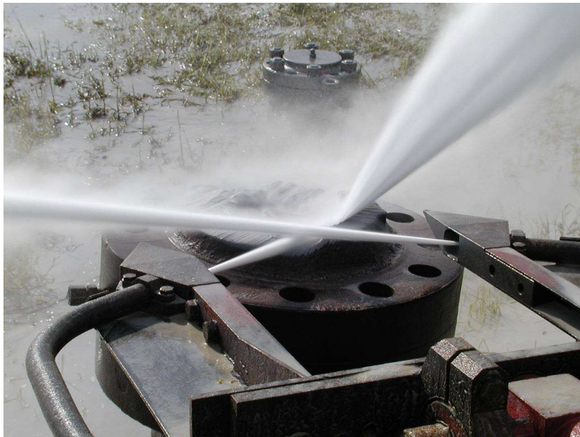
Рисунок 11 – Робота різача з гнутими трубами
