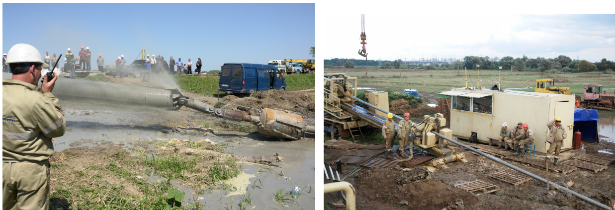
Рисунок 1 – Робочий майданчик для проведення ГНБ
