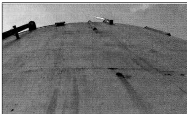
Рис. 1. Образование гофр и вмятин на стенке после разворачивания рулонов.
