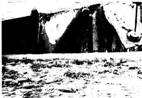
Рис. 1.16. Ділянка зруйнованого покриття резервуару
