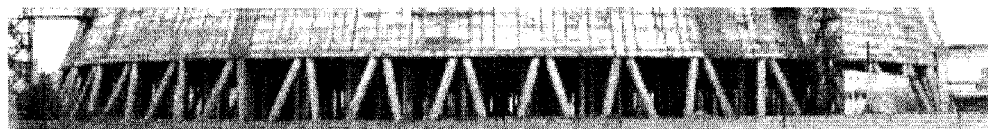
Рис. 3.26. Залізобетонні колони нахиленої колони гирині
