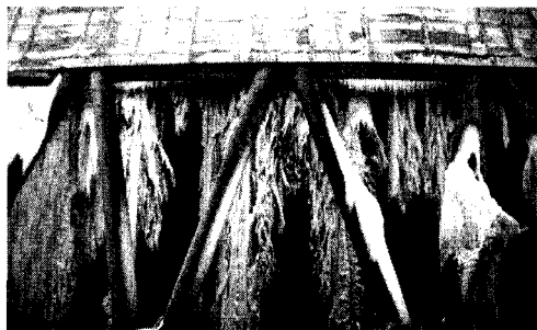
Рис. 3.34. Обледеніння нижнього опорного кільця жорсткості та нахиленої колонади градирні
