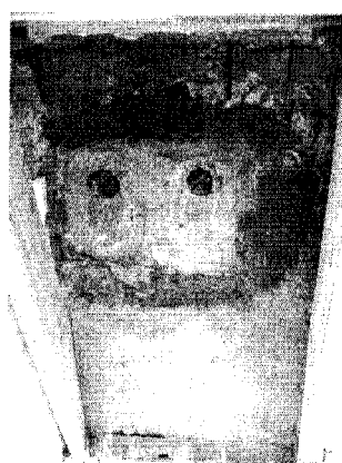
Рис. 5.77. Зондування міцності бетону опорного кільця
