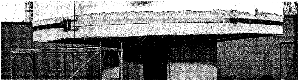
Рис. 5.60. Підсилення кільцевої балки перекриття на відм. +8,75 м сталевим стяжним кільцем
