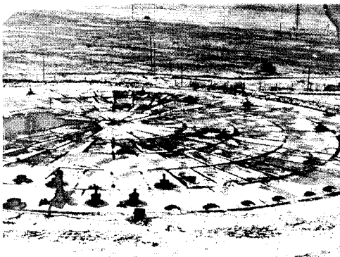
Рис. 1.14. Резервуар для нафти з ділянкою зруйнованого покриття
