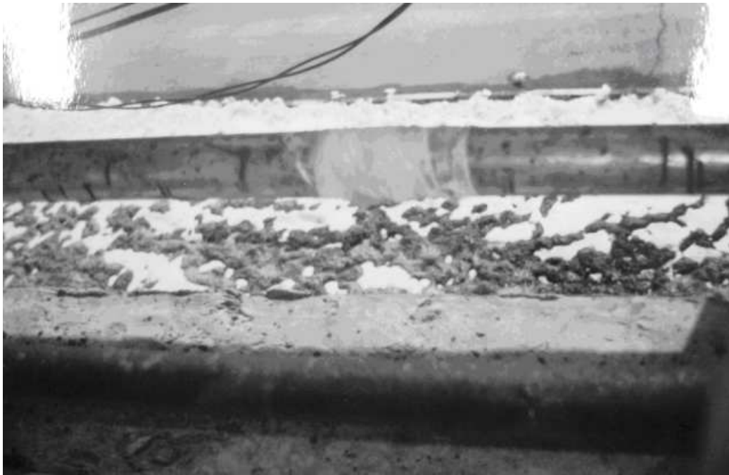
Рисунок 9.20 - Трубопровід технологічного повітря з намотаним бандажем 11 листопада 2003р.
