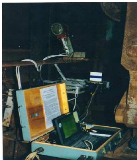
Рисунок 1 - Экспериментальная мобильная система контроля типа «Орион-1», смонтированная на крыше скипа ш. «Южная» концерна горнорудных и нерудных компаний Украины "Укррудпром" (на воздухоподающем стволе)
