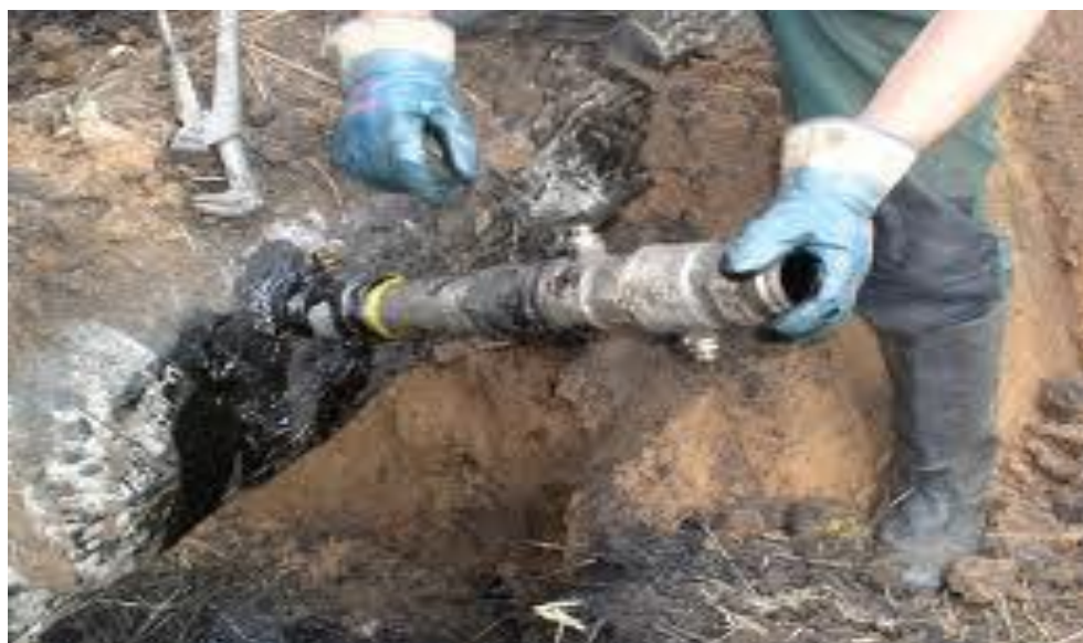
Рисунок 1.10 – Несанкціоноване врізання в нафтопровід «Дружба»
