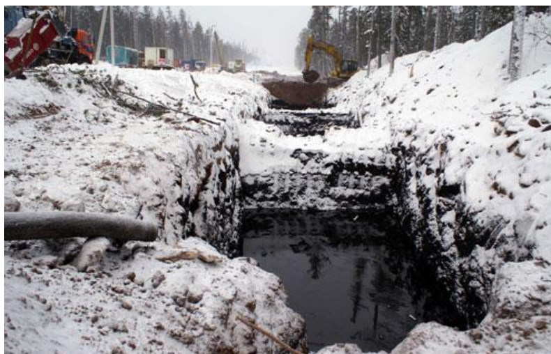
Рисунок 1.8 – Розгерметизація нафтопроводу Східний Сибір – Тихий океан в Приамурському краї, Росія
