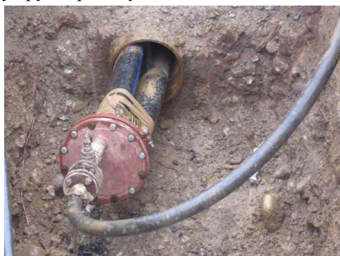
Рисунок 3 – Розширення С-подібного лайнера тиском пари
