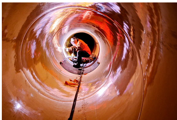
Рисунок 9 – Внутрішньотрубний ремонт дефекту стінки труби наплавленням ручним дугувим зварюванням
