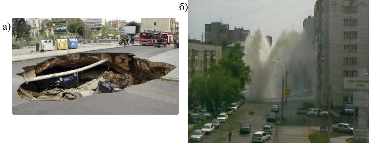
а) – провалювання автомашин у вимити порожнину; б) – фонтан води
