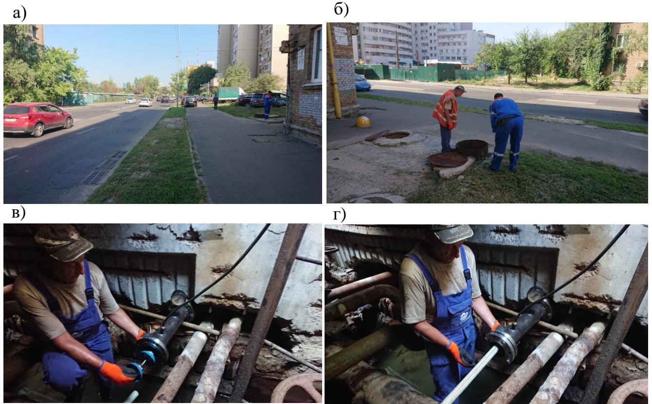
а) – вулиця Жилянська в місці перетинання її теплопроводом; б) – оглядання колодязя; в) – запускання поршня; г) – протягування поршнем нового поліетиленового трубопроводу
