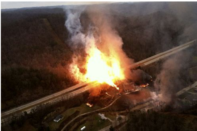
Рисунок 1.1 – Фрагмент аварії на газопроводі «Уренгой – Сургут – Челябінськ» 1982 року
