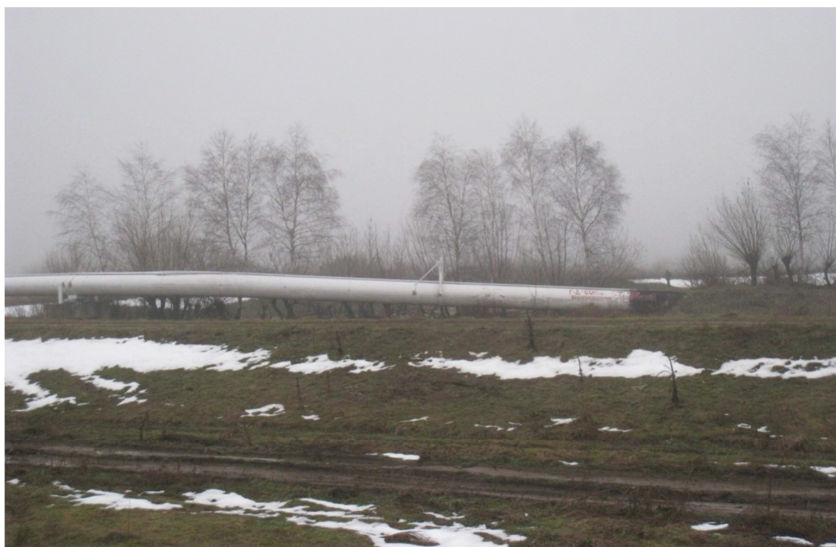
Рисунок 4.10 – Ділянка газопроводу із переходу підземного прокладання у надземне (газопровід «Союз»)
