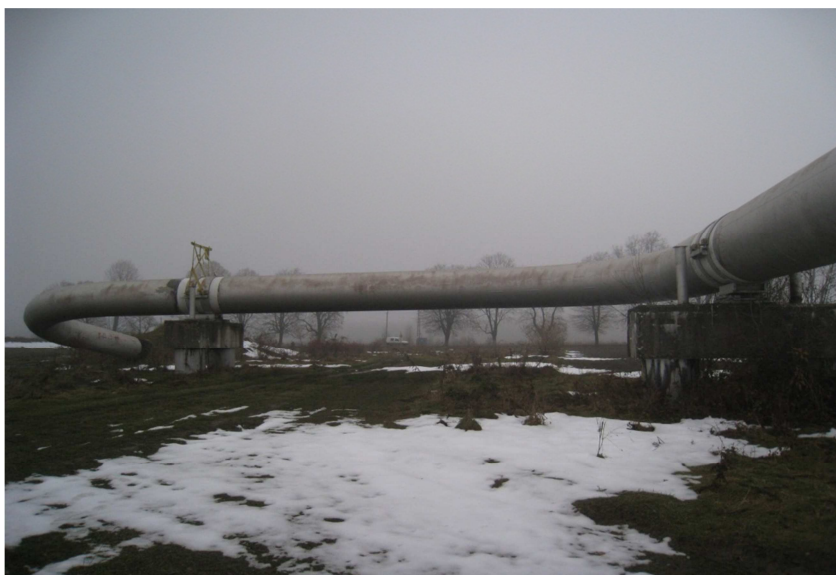
Рисунок 5.9 – Ділянка газопроводу із переходу підземного прокладання у надземне (газопровід «Уренгой – Помари – Ужгород»)
