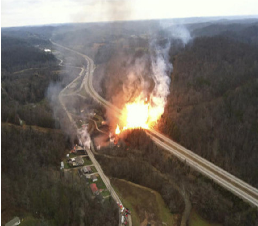
Рисунок 5.1 – Руйнування трубопроводів у спільному технічному коридорі
