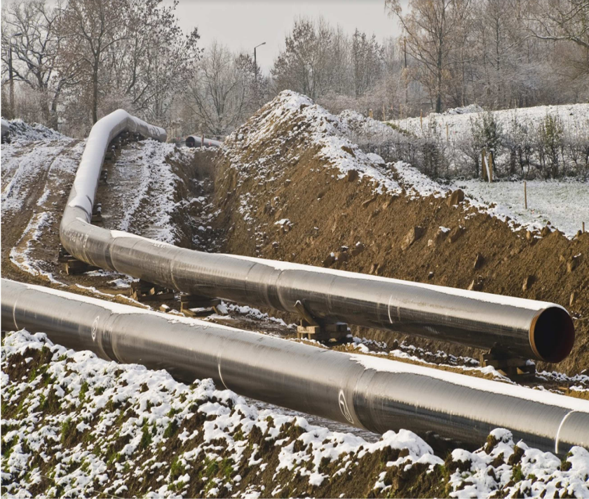
Рисунок 5.5 – Взаємне прокладання двох ниток трубопроводів
