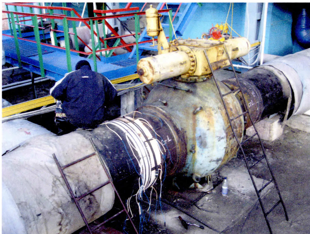
Рис. 1.5. Заміна кульового крана Ду1000 на ділянці технологічної обв'язки КС «Тернопіль»
