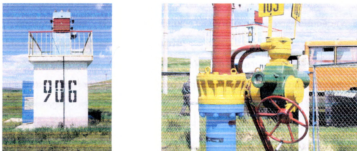
Рис. 3.12. Контрольний пункт телемеханіки на 986 кілометрі нафтопроводу
