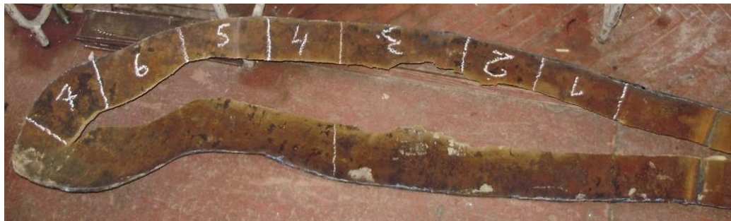
Рисунок 4.5 – Місце руйнування труби
