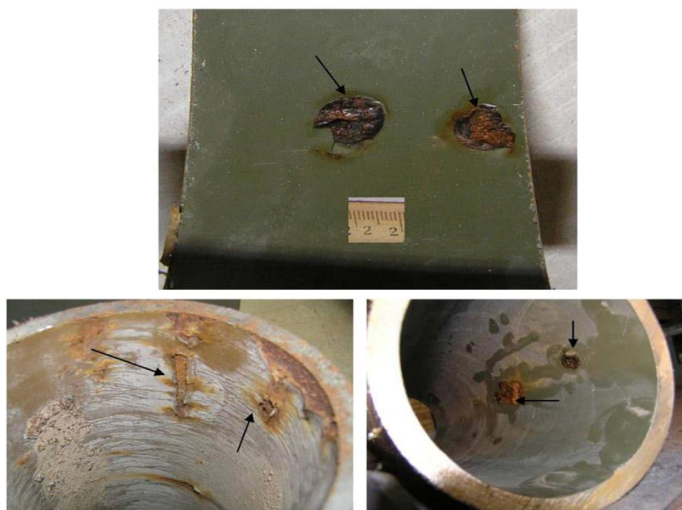
Рисунок 1.5 – Корозійні пітинги на внутрішній поверхні БТ [193]
