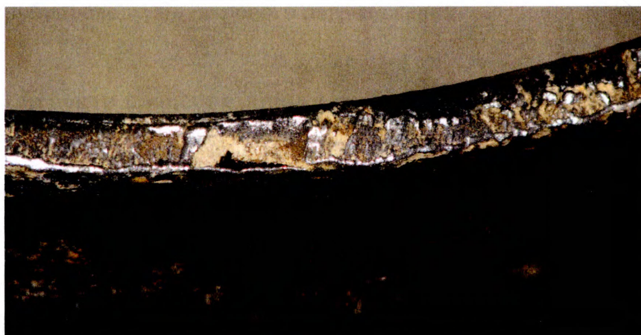
Рисунок 1.2 - Фрагмент труби з суцільною тріщиною в зоні зварного шва і основного металу
