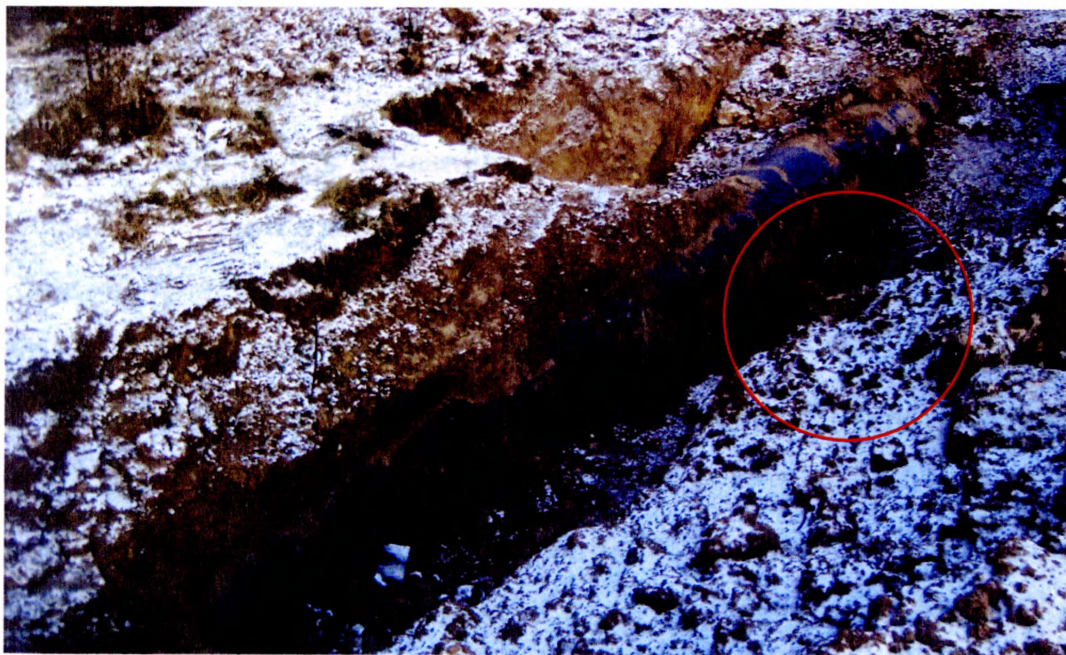
Рисунок 1.5 - Ділянка МГ “Івацевичі-Долина III нитка”, яка опирається на кам'яну плиту
