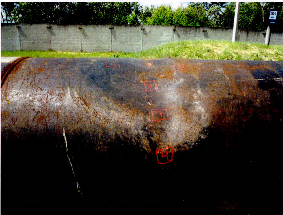
Рисунок 4.4 – Ділянка випробувального резервуара з вм'ятиною
