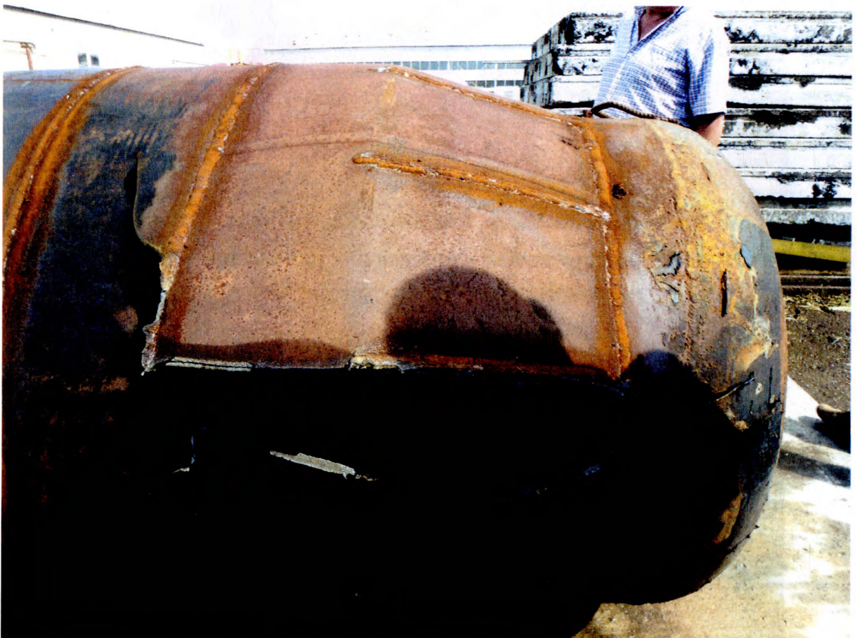
Рисунок 4.17 – Ділянка руйнування випробувального резервуару
