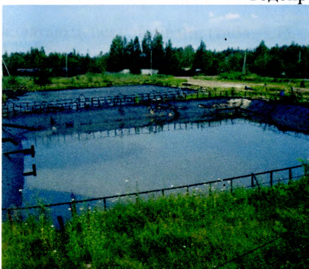
Технологічні ставки облаштовані протифільтраційним екраном
