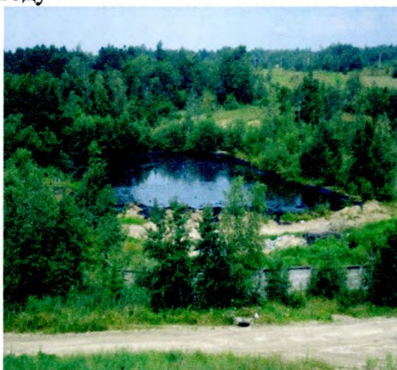
Земляні амбари додаткового відстою зворотних пластових вод
