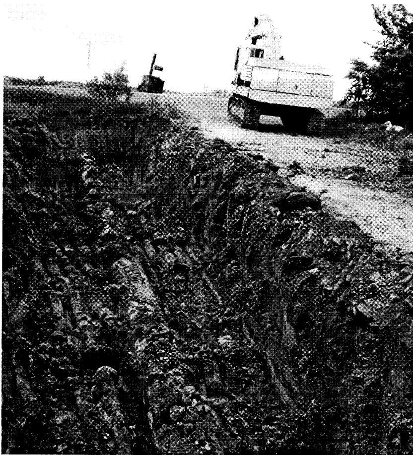
Рис. 2.1. Ремонтна ділянки трубопроводу
