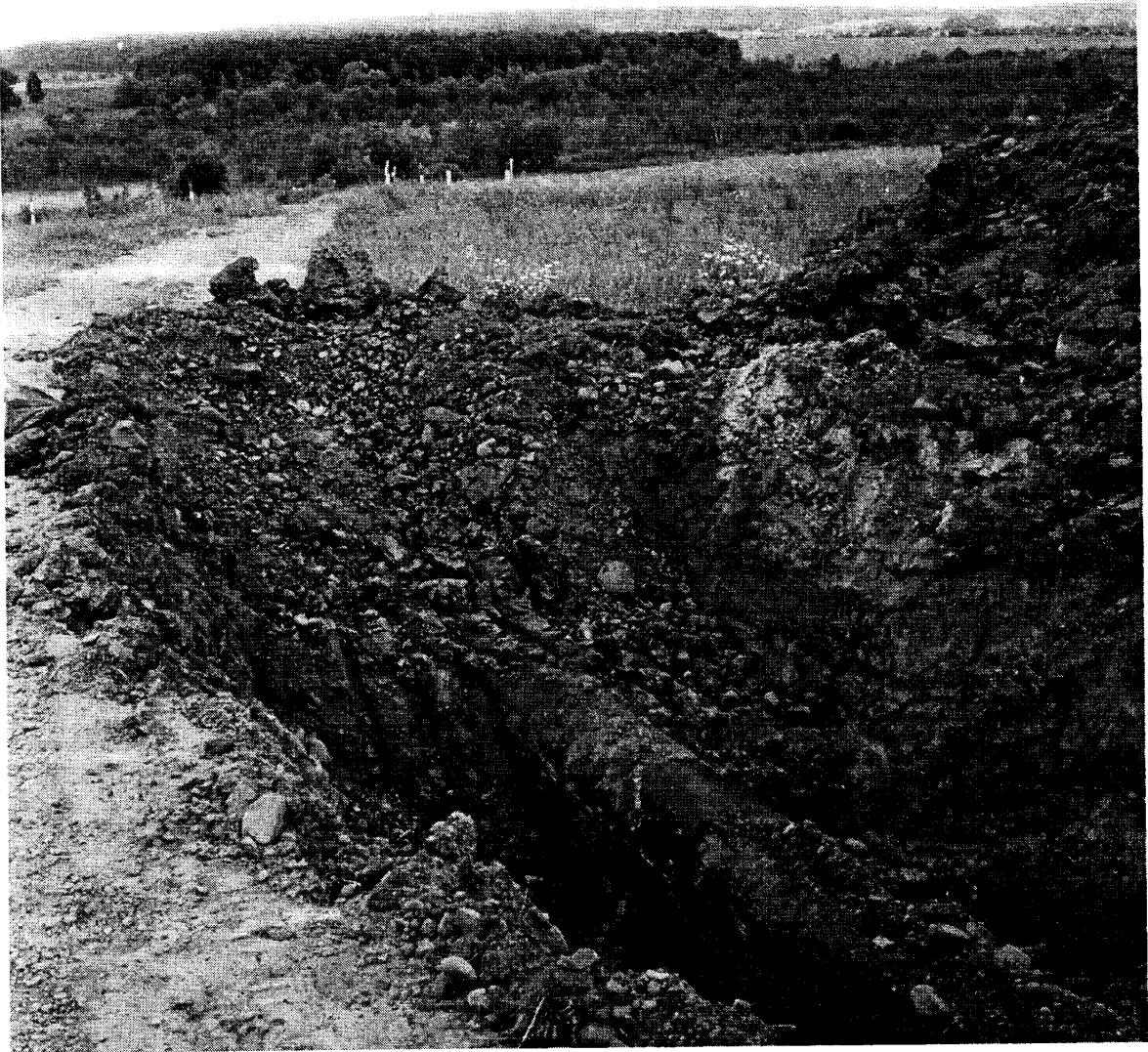
Рис. 1.4. Ділянка трубопроводу, яка піддається короткочасному впливу внаслідок дії тиску рухомих навантажень при русі по польовій дорозі
