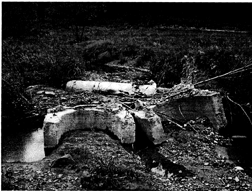
Рис. 1.2. Розмита ділянка магістрального газопроводу внаслідок повені 2008 р. в с. Витвиця Долинського району Івано-Франківської області
