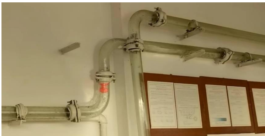
Рисунок 9 – Застрягання гантелеподібного трикулевого очисного поршня зі силіконового компаунда в місці резинового ущільнення з'єднання скляних труб і перетікання через нього повітря
