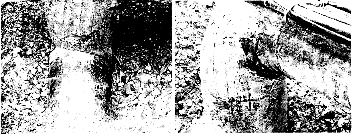
а) наскрізні дефекти ізоляції значної площі
