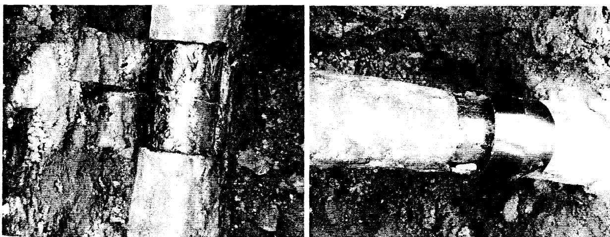
Рисунок 3.7 – Вигляд створеного відшарування ізоляції з шаром електроліту
