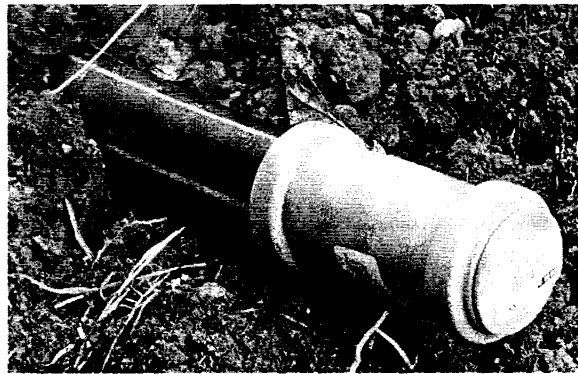
Рис. 6 – Вихід пластикового трубопроводу на поверхню
