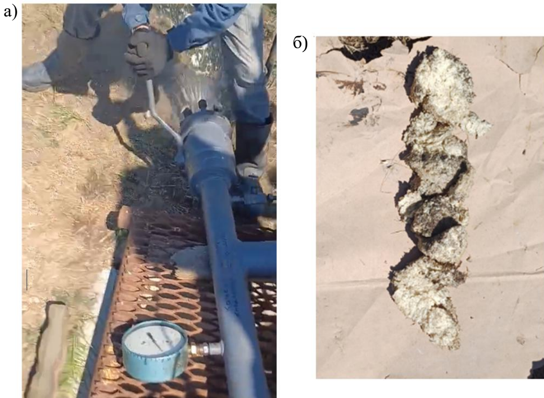
а) – вихід очисного поршня через рівнопрохідний кран стаціонарного вузла запускання; б) – шматки поршня
