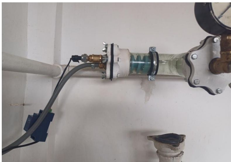
Рисунок 3.18 – Камера запускання поршнів
