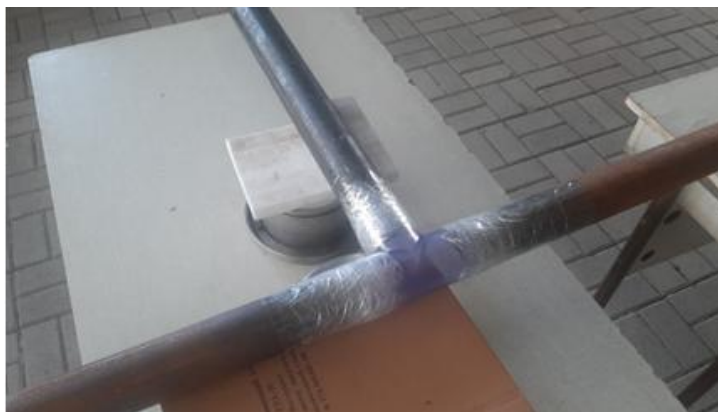
Рисунок 5.9 – Змонтований пластиковий трійник на сталевому трубопроводі
