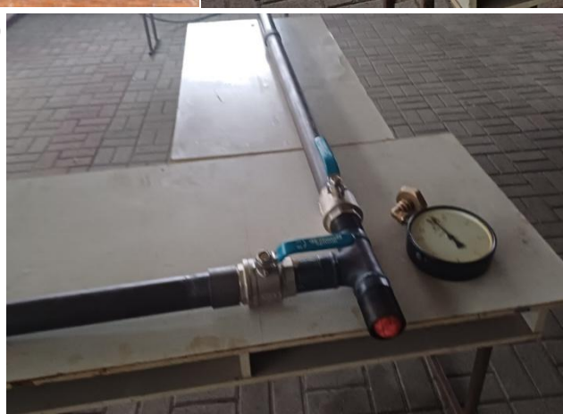
Рисунок 6.16 – Приймання очисного поршня у металевому вузлі
