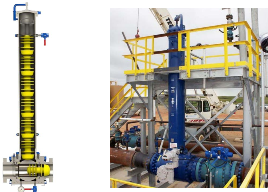
Рисунок 1.54 – Сферичний кран для запускання декількох поршнів
