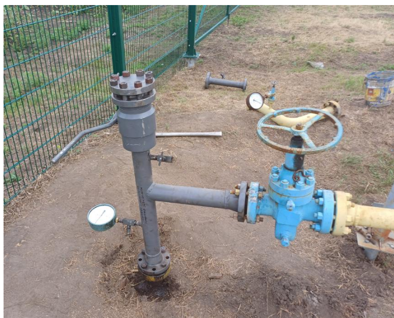
Рисунок 7.11 – Змонтований вузол під'єднання мобільної камери запускання очисних поршнів
