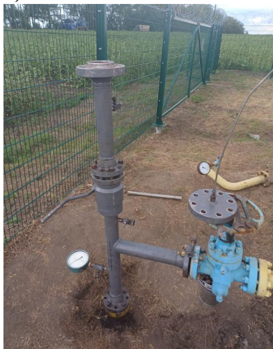
а) – демонтована заглушка; б) – приєднана мобільна камера запускання очисних поршнів
