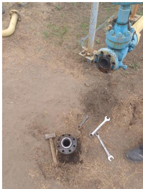
Рисунок 7.8 – Демонтаж крутовигнутого відводу лінії подачі газу в шлейф свердловини
