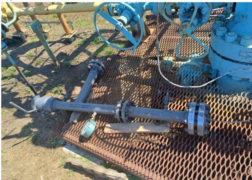
а) – запасування поршня із пружно-полімерної композиції; б) – під'єднання мобільної камери запускання
