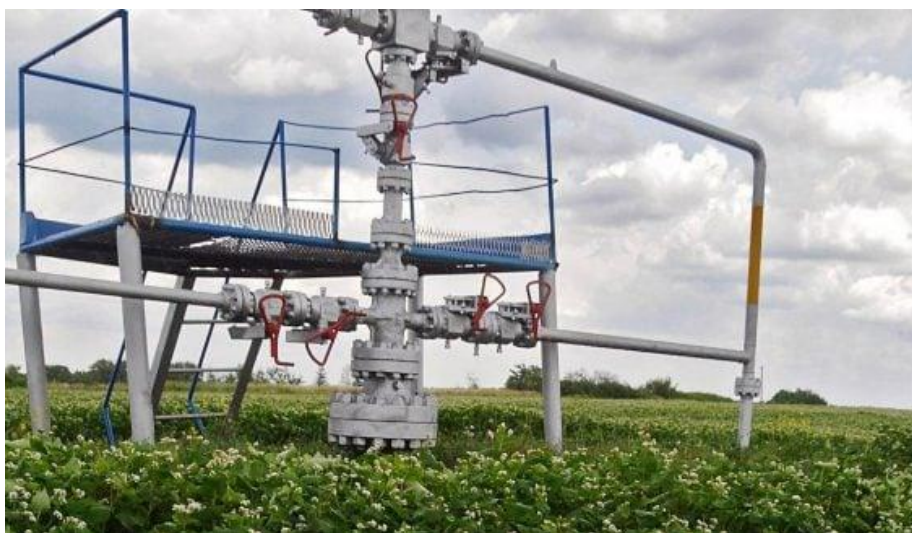
Рисунок 6.9 – Обв’язка гирла газової свердловини [299]
