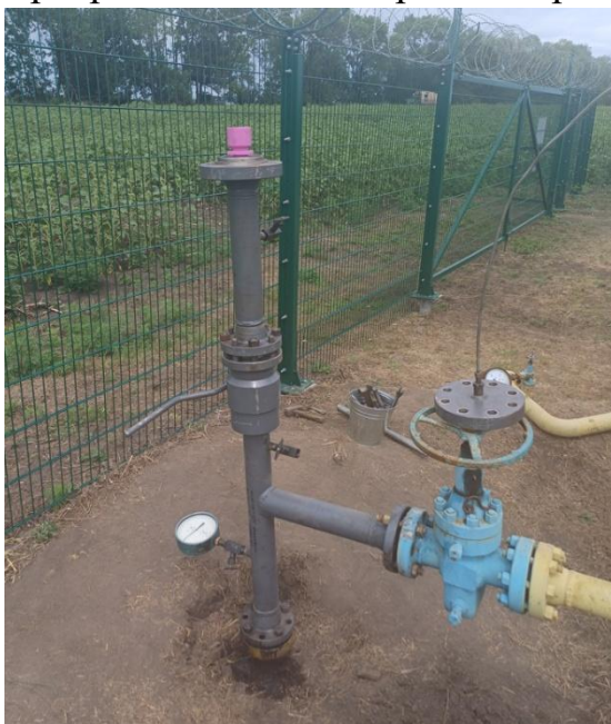
Рисунок 7.13 – Запасування гантелеподібного-дводискового поршня із силіконового компаунда в мобільну камеру запускання очисних поршнів
