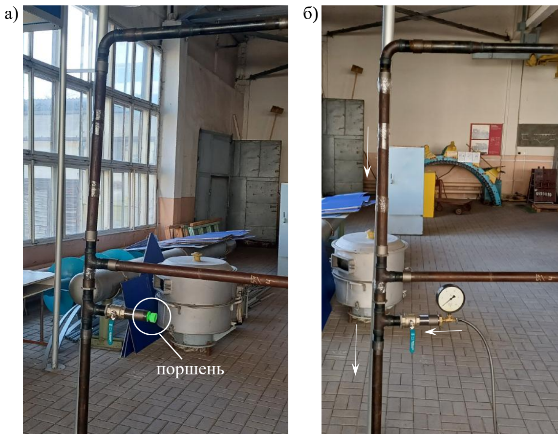
а) – запасування очисного поршня; б) – запускання очисного поршня
