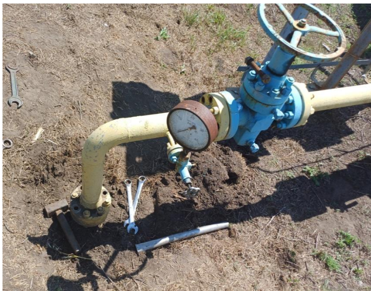
Рисунок 7.8 – Демонтаж крутовигнутого відводу лінії подачі газу в шлейф свердловини
