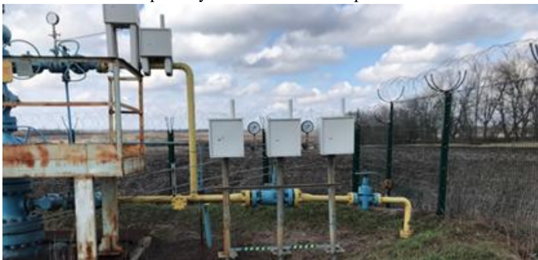
Рисунок 7.2 – Лінія подачі газу в шлейф свердловини № 101 Західно-Старовірівського ГКР
