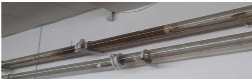
Рисунок 3.22 – Очищення горизонтальної ділянки трубопроводу дослідним зразком очисного поршня
