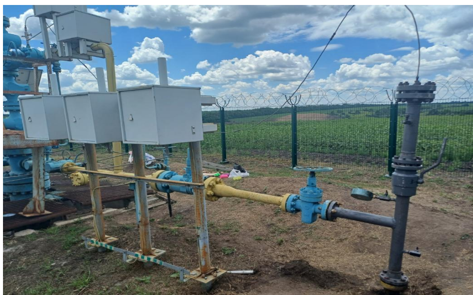
Рисунок 7.14 – Запускання очисного поршня за допомогою мобільної камери
