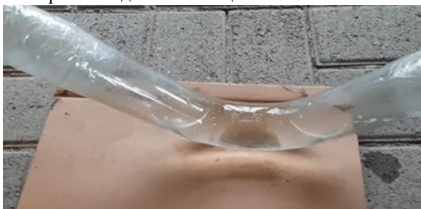
Рисунок 3.33 – Залишок води в пониженій ділянці трубопроводу після проходження очисного поршня
