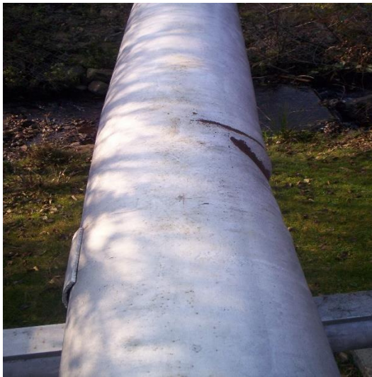
Рисунок 5.8 – Гофри в трубах надземної ділянки
