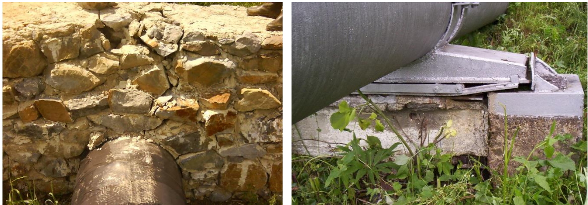
Рисунок 1.11 – Руйнування опорних елементів надземної ділянки: а) місце входу в ґрунт (оголовок); б) просідання ригеля опори
