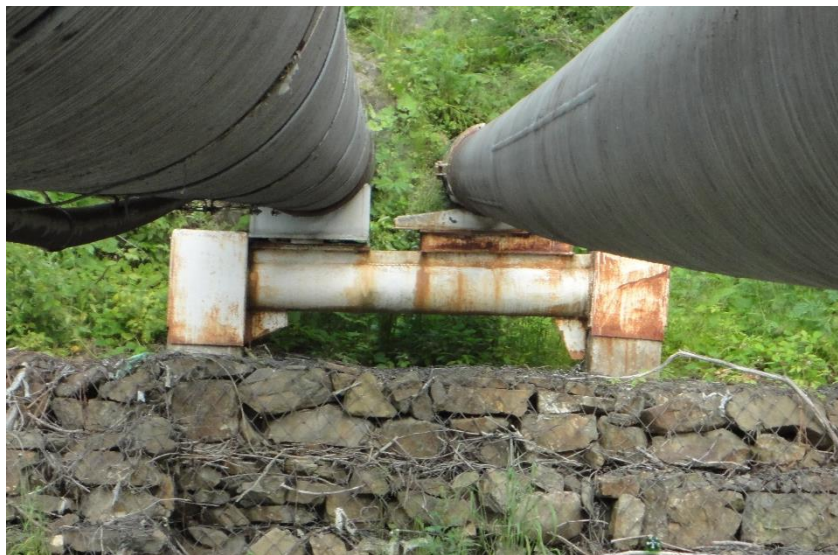
Рисунок 2.2 – Загальний вигляд першої (за течією нафти) опори після ремонту
