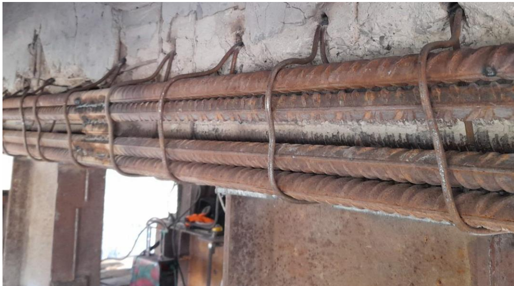
Рисунок 5.20 – Ремонтована ділянка залізобетонного елемента
