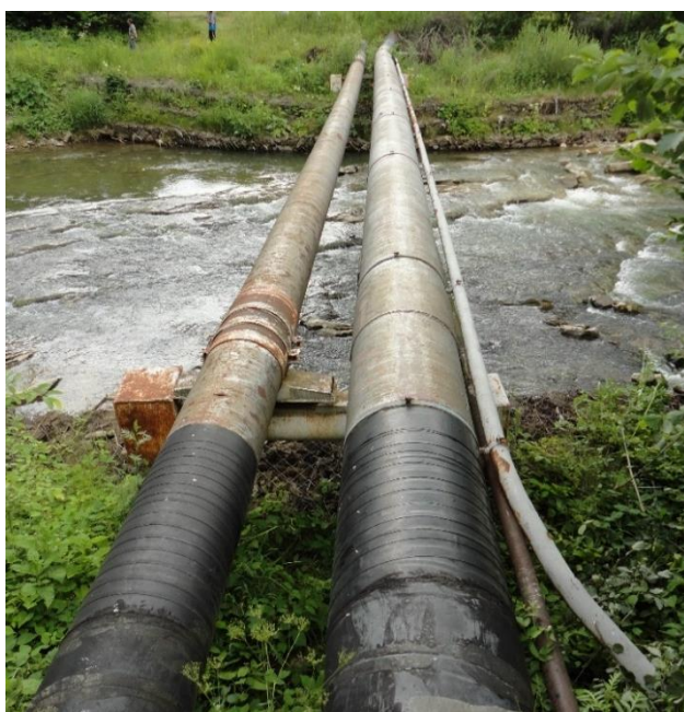
Рисунок 2.1 – Загальний вигляд надземних переходів № 29 нафтопроводів «Дружба»
