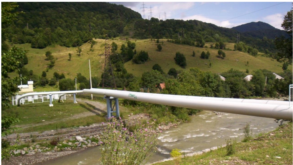
Рисунок 2.5 – Типовий надземний балковий перехід у кожусі
